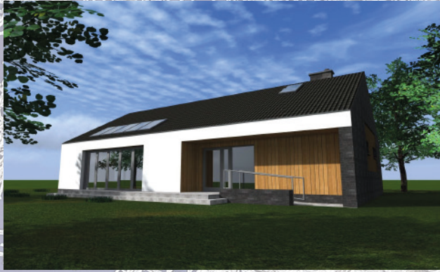
Budowa świetlicy w Roszczycach
